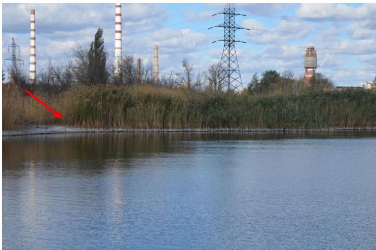
Рисунок 18. Накопичувач № 4, стрілкою позначено білий наліт невідомого походження на межі водної фази і нижньої частини очерету. З огляду на склад відходів у накопичувачі можна припустити, що оксид кальцію реагує із водою, що призводить до утворення нової речовини – негашене вапно
