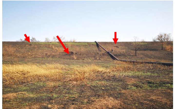
Рисунок 41. Сліди потрапляння снарядів у греблю накопичувача БАС (червоні стрілки)
