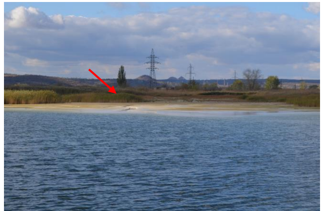
Рисунок 17. Накопичувач № 3, стрілкою - сухі пляжі, пиління яких ймовірно за посушливої погоди та сильного вітру
