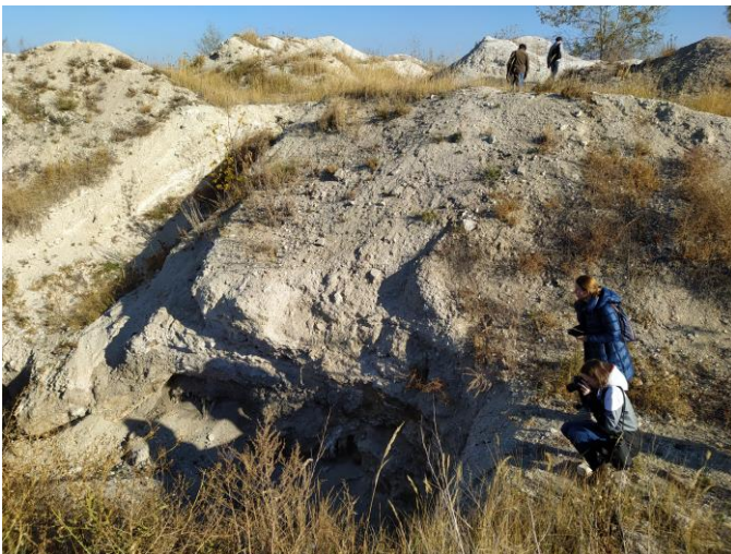
Рисунок 31. Накопичувач № 2: осипання укосу, утворення воронки значних розмірів, розмиття дощовими водами
