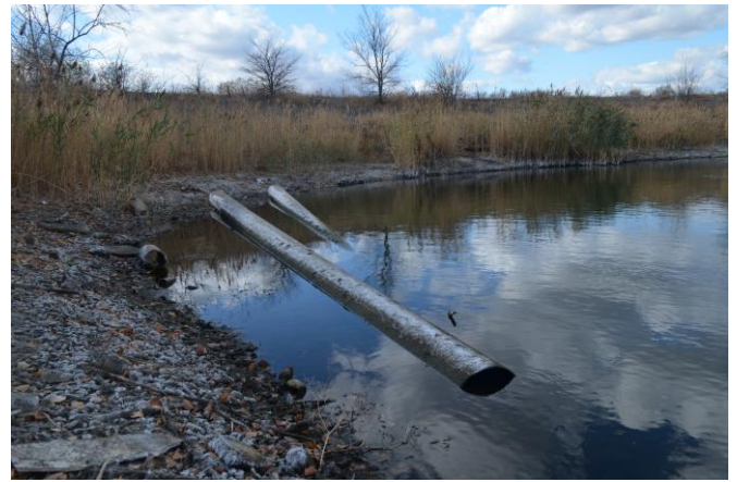
Рисунок 19. Накопичувач № 4, залишки трубопроводу без ознак спеціального облаштування
