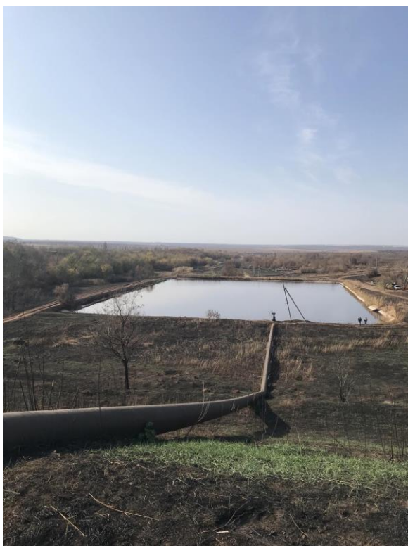
Рисунки 37. Трубопровід відкачування відходів із накопичувача БАС у ставок-розріджувач. Вид з греблі накопичувача
