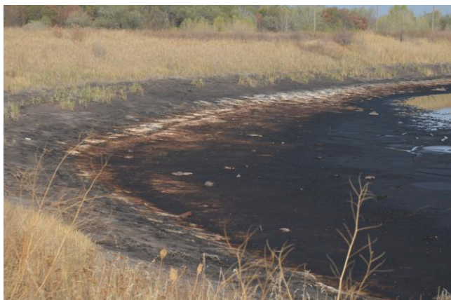
Рисунок 13. Сліди відходів на внутрішніх укосах дамби секції № 5
