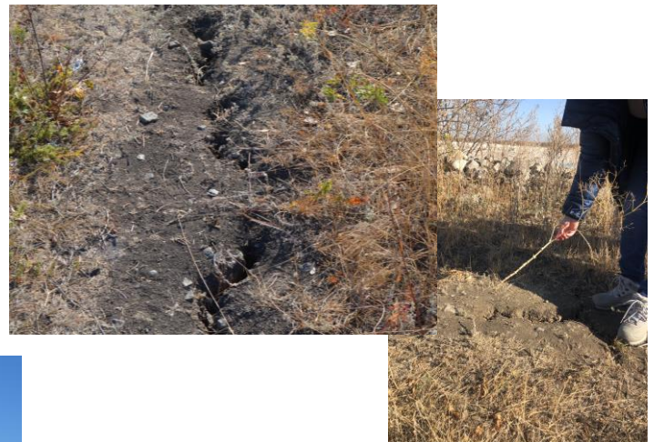
Рисунок 28. Тріщини на поверхні дамби накопичувача № 3, глибина більше за довжину палиці в 70 см
