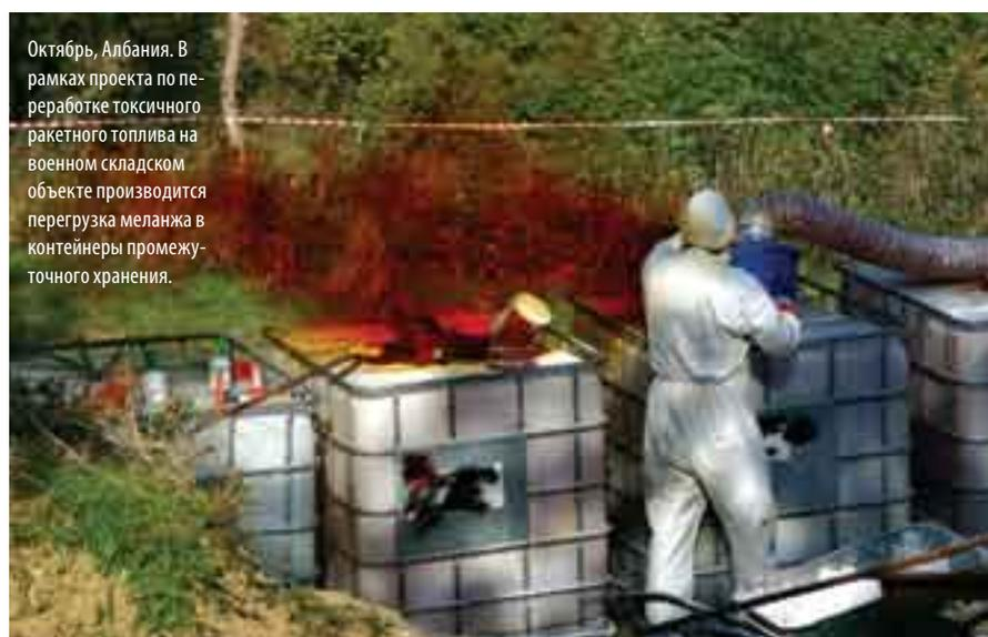
Октябрь, Албания. В рамках проекта по переработке токсичного ракетного топлива на военном складском объекте производится перегрузка меланжа в контейнеры промежуточного хранения.
