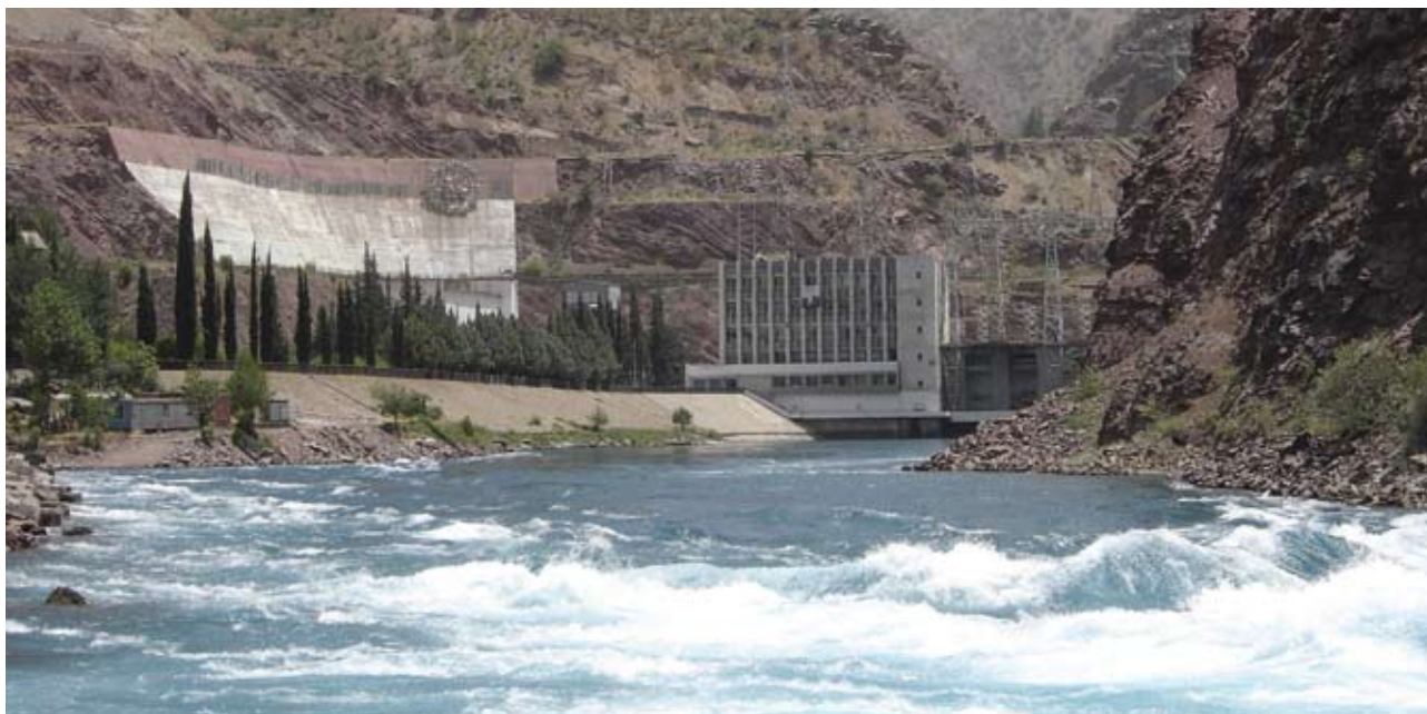
В ходе конференции ее участники ознакомились с работой Нурекской ГЭС, которая находится в глубоком ущелье в долине реки Вахш в западном Таджикистане. (ОБСЕ/Саба Нордстром)
