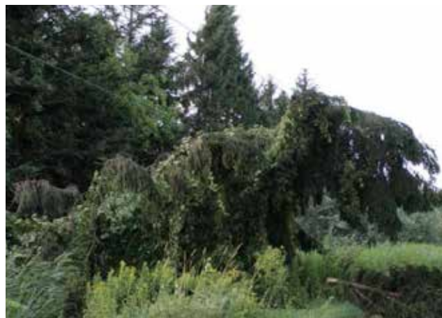
Рис. 24. Повреждение энерголиниям электропередачи порывом ветра.
