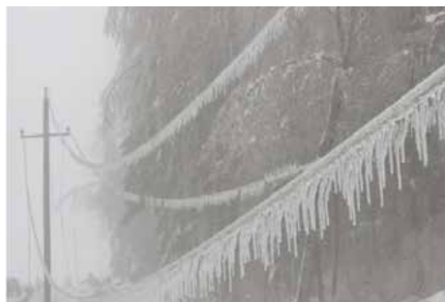
Рис. 25. Обледенения, повредившие линии электропередачи в Каринции, Австрия, в зимний период 2014 года.
