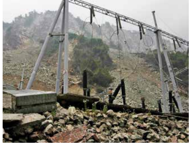
Рис. 39. Поврежденная гидростанция «Генгда» (слева) и соседняя подстанция (справа) вблизи эпицентра Вэньчугского землетрясения (Фото: Минчон Лю (Mingchong Liu)).
