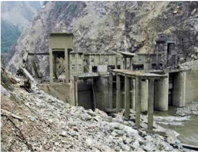
Рис. 39. Поврежденная гидростанция «Генгда» (слева) и соседняя подстанция (справа) вблизи эпицентра Вэньчугского землетрясения (Фото: Минчон Лю (Mingchong Liu)).
