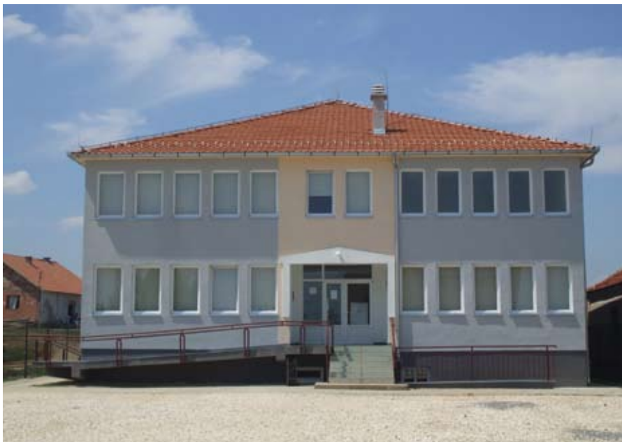
NEDAVNO IZGRAĐENI CENTAR ZA ZAJEDNICE U AŠKALIJSKOM NASELJU „DUBRAVĚ/DUBRAVA“ U FERIZAJ/ UROŠEVCU. OPŠTINA PLANIRA DA ZAVRŠI RAZVOJ INFRASTRUKTURE IZGRADNJOM IGRALIŠTA I ŠKOLE U BLIZINI.
