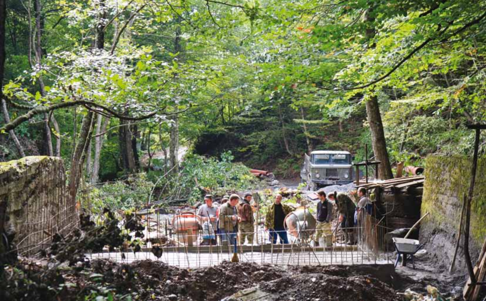
Ремонтные работы водозабора водораспределительной сети Знаури, которая восстанавливается в рамках финансируемого Европейским Союзом и реализуемого под руководством ЦПК проекта ОБСЕ по укреплению доверия в регионе после конфликта в Грузии в августе 2008 года. От водозабора по девятикилометровым трубам питьевая вода будет поступать в Знаури. (ОБСЕ/Эммануэл Анкетил)
