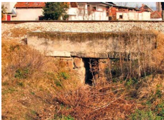
Slika 15: Karakterističan način povećanja nosivosti železničkog propusta smanjenjem otvora
