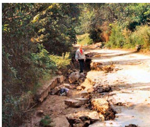
Slika 44: Regionalni put Veliko Gradište – Ram prosečen bujicom (1999)
