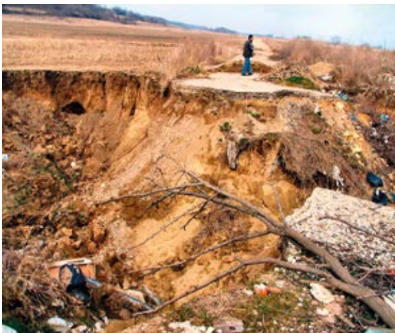
Slika 27: Put presečen bujičnom jarugom male ukupne denivelacije
