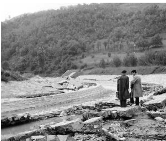
Slika 7: Srušena regulacija bujičnog vodotoka
