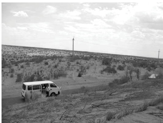
Устилочная механическая защита вдоль дороги в пос. Кызыл Рават
