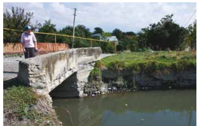
Dans le cadre du projet de gestion de l'eau d'irrigation de Nikosi, géré par l'OSCE, des pompes à eau et des conduites ont été installés pour alimenter le large canal d'irrigation de Saltvisi en eau douce, au profit des agriculteurs touchés par le conflit d'août 2008 en Géorgie. Juin 2011. (OSCE/Emmanuel Anquetil)
